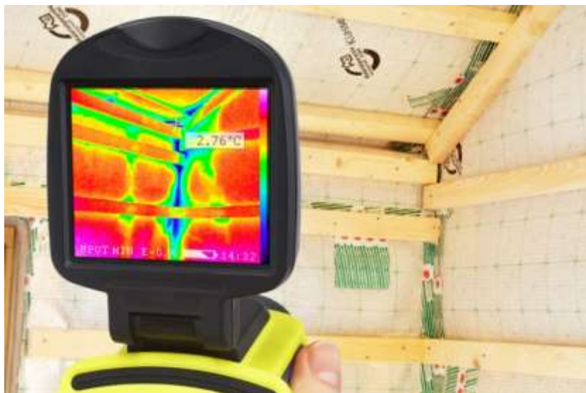
Рис.3. Проверка внутреннего состояния помещения тепловизором
