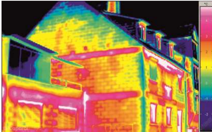
Рис.2. Общий вид здания через тепловизор
